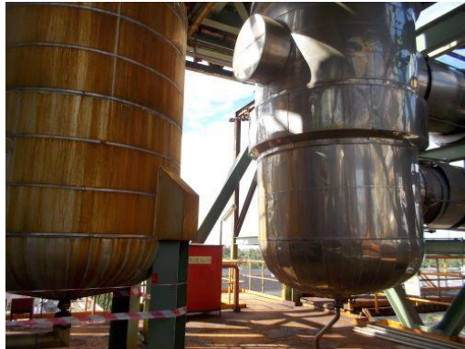
รูปที่ 3-1 Waste Gas Treatment Off Gas เพื่อบำบัด NO x
