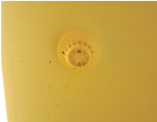
รูปที่ 3-39 Heat Detector
