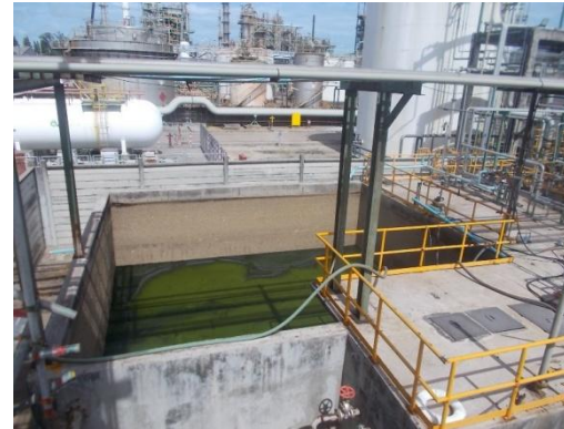
รูปที่ 3-19 Oily Sewer
