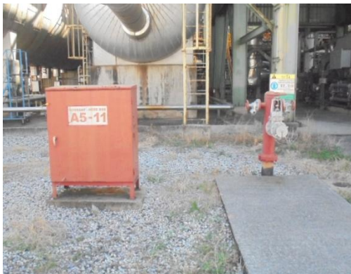
รูปที่ 3-41 Water Hydrant and Hose Box
