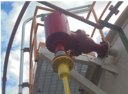
รูปที่ 3-49 Fixed Foam Discharge Outlet
