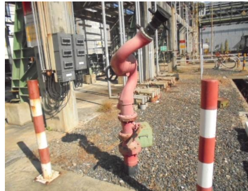
รูปที่ 3-46 Fixed Water Monitor
