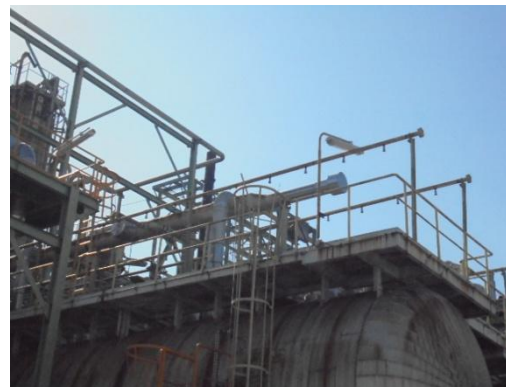
รูปที่ 3-50 Fixed Foam Spray System
