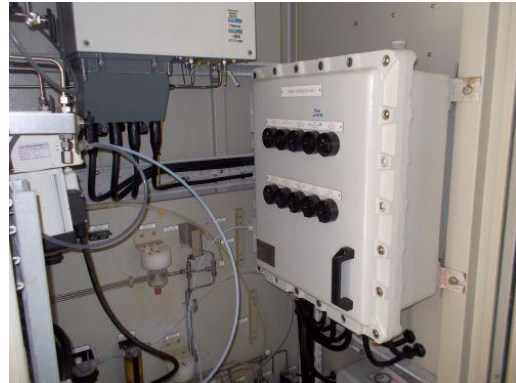
รูปที่ 3-2 เครื่องตรวจวัดความเข้มข้นของมลพิษ ทางอากาศอย่างต่อเนื่อง (CEMS)
