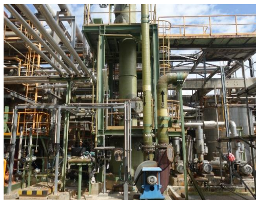
รูปที่ 3-5 ระบบกำจัดกลิ่นกำมะถัน (Sulfur Scrubber 4110-S1)
