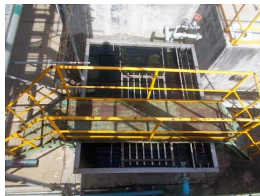
รูปที่ 3-11 Oil Separation System
