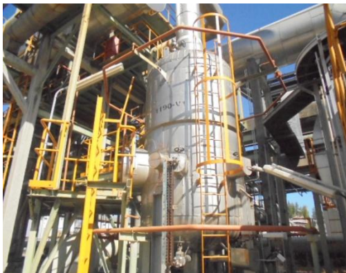
รูปที่ 3-43 Fixed Water Spray System
