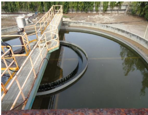
รูปที่ 3-14 Flocculation & Sedimentation
