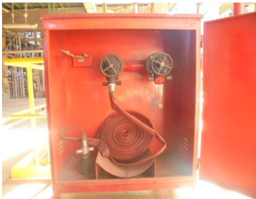
รูปที่ 3-47 Stand Pipe and Hose System
